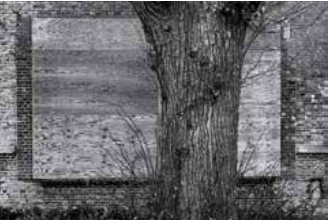
1 Bomen (2019). Voormalige school van het verlaten wierde dorp Weiwerd. Het gebouw is in september 2018 door brand verwoest.
